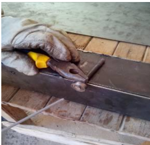
FIGURA 12- Soldagem dos rolamentos à barra de aço
